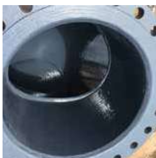
Revestimiento de lavadores de gases
